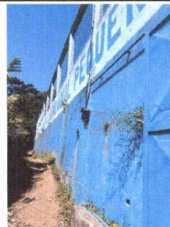
Foto 6: Se observan el muro de contención y perimetral que da acceso al establecimiento, con ciertas partes dañadas y pintura deteriorada.
